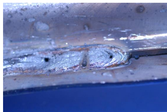
写真133-02 亜鉛メッキ鋼板CO 2 重ねすみ肉溶接のスタート部に発生したピットとその外観
